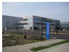
FPD製造装置工場
