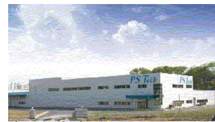
部品洗浄工場
