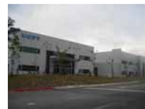
部品洗浄工場
