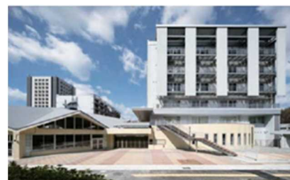
大阪大学吹田キャンパス内 センテラス棟
