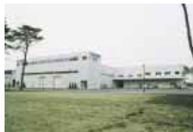
新築された加工センター
