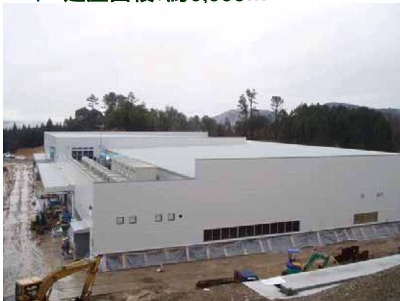
大型ドライポンプ工場 (2005年2月竣工予定)
