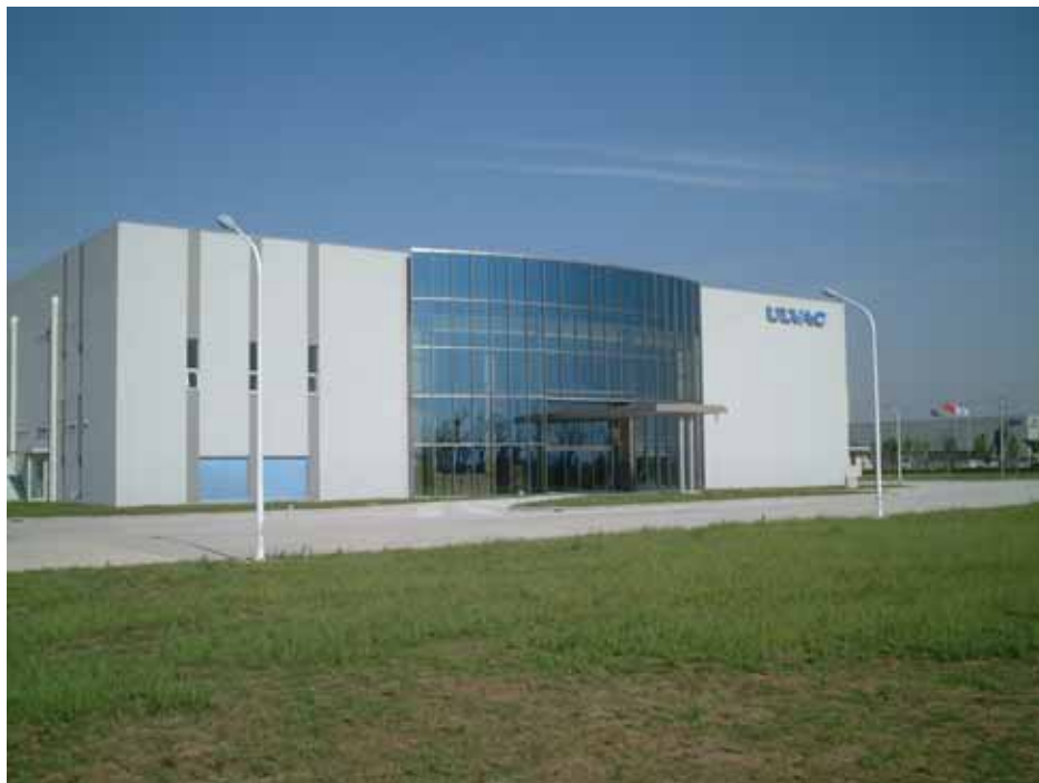
愛発科真空技術(蘇州)有限公司(アルバック蘇州)外観
