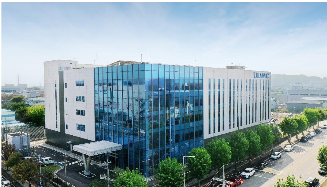
韓国 平澤市「Technology Center PYEONGTAEK」
