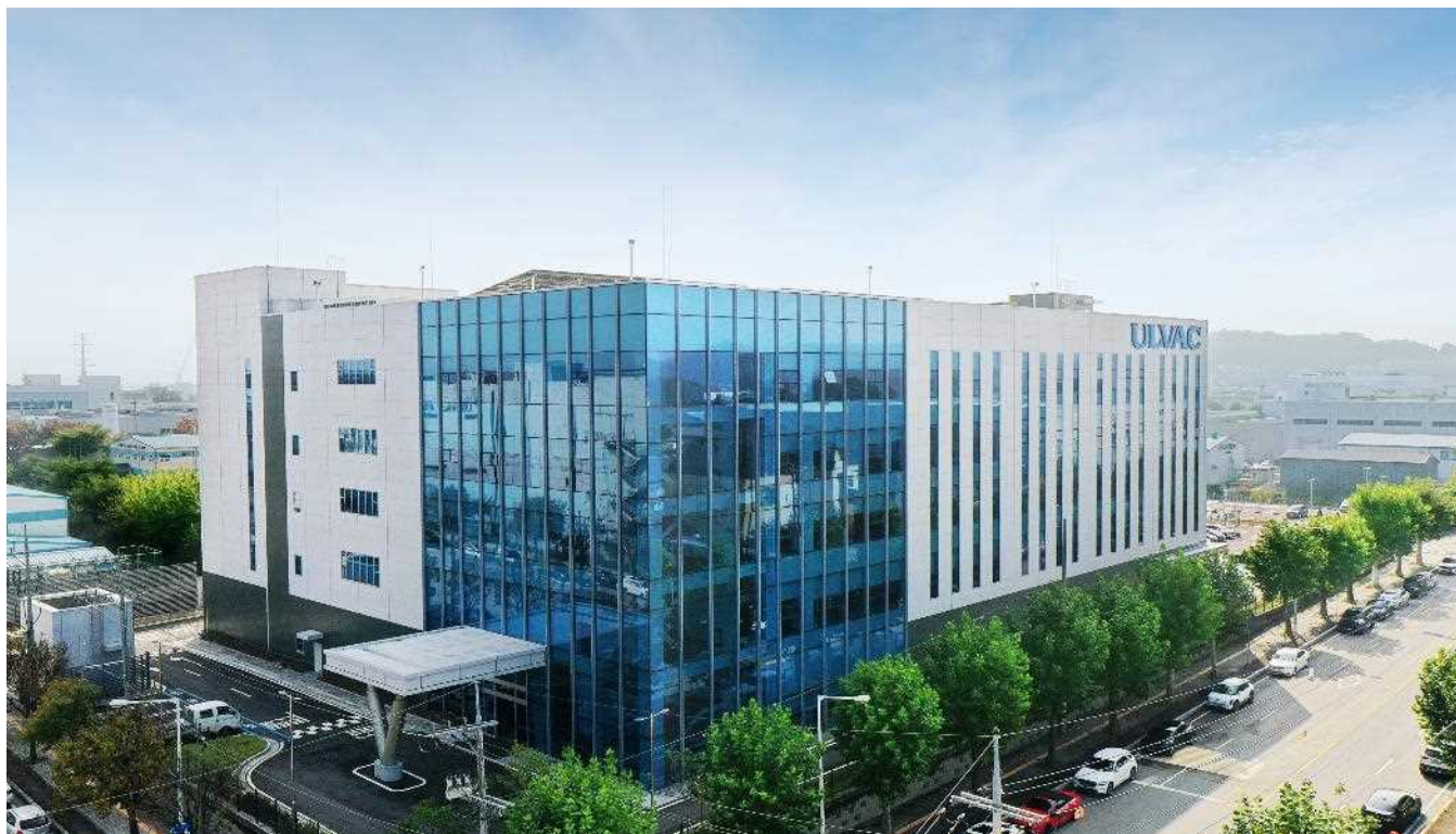
韓国 平澤市「Technology Center PYEONGTAEK」
