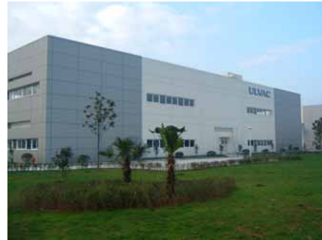
コンポーネントを量産する 寧波アルバック
