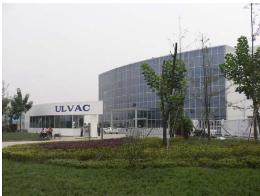
漏れ検査装置などの生産工場 (05/11竣工)
