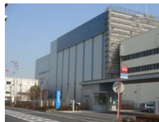
第1期(2007年2月竣工) (茅ヶ崎本社工場)
