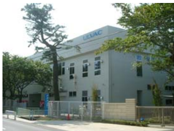
(2006年9月竣工) (茅ヶ崎市)
