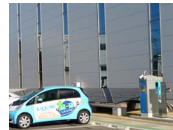
茅ヶ崎本社工場に設置した急速充電システム
