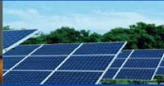
Photovoltaic 太陽電池
