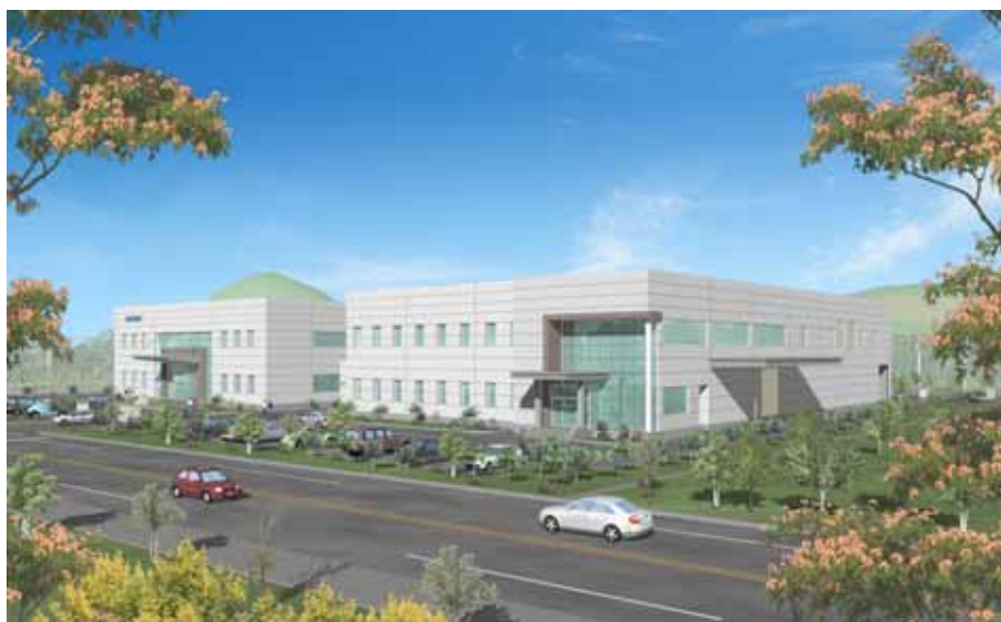
CSソリューション工場 (06/7竣工予定) (工場建設中)
